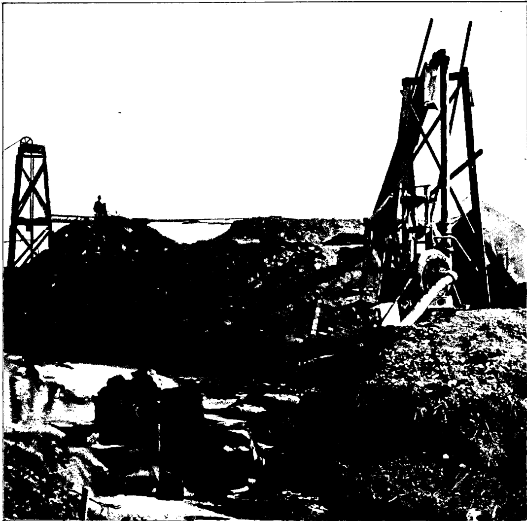
Bild 54: Minenarbeit am Wunderbach bei Nome. Die Hebung des Bachwassers geschieht durch eine Rotationspumpe.
