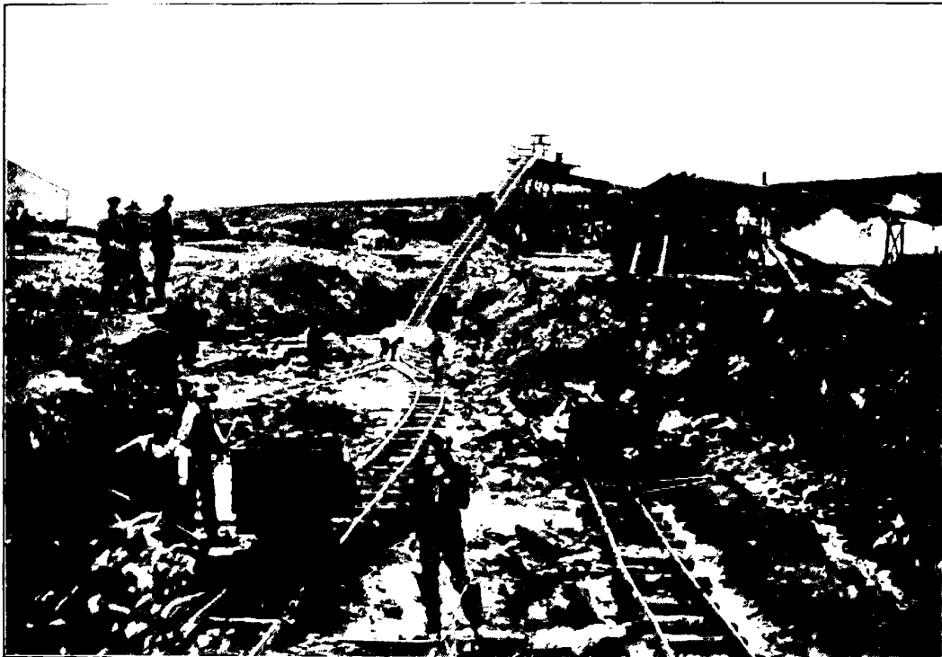
Bild 57: Tagebau, bei welchem die Kiese im Kippwagen auf Schienen bis zur Höhe des Wäschers geführt werden.
