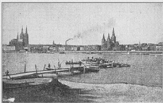
155. Pioniere beim Bau einer Pontonbrücke (Bau der Pontonstrasse). Nach einer Photographie von Karl Scholz, Köln-Deutsch.
