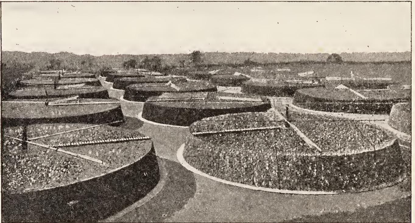
Fig. 112. Ansicht der Wilmersdorfer Tropfkörper (in Stahnsdorf bei Berlin).<sup>1)</sup>
