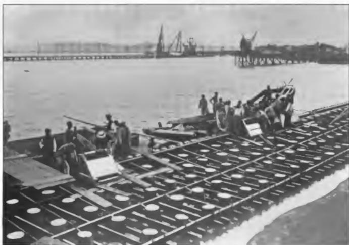
Einbetonieren des Pfahlrostes der Kohlenmole.
