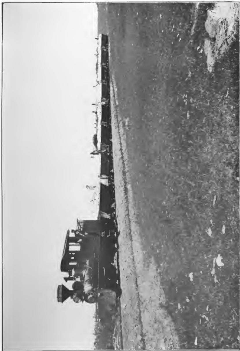
Steintransport durch eine Feldbahn mit Lokomotivbetrieb
