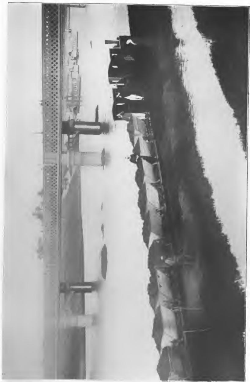
**Erdtransport durch eine Feldbahn mit Lokomotivbetrieb
