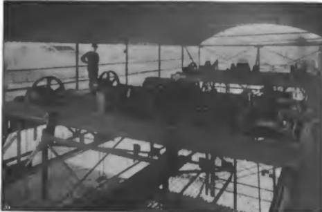
Der elektrische Antrieb des Hebewerks.
